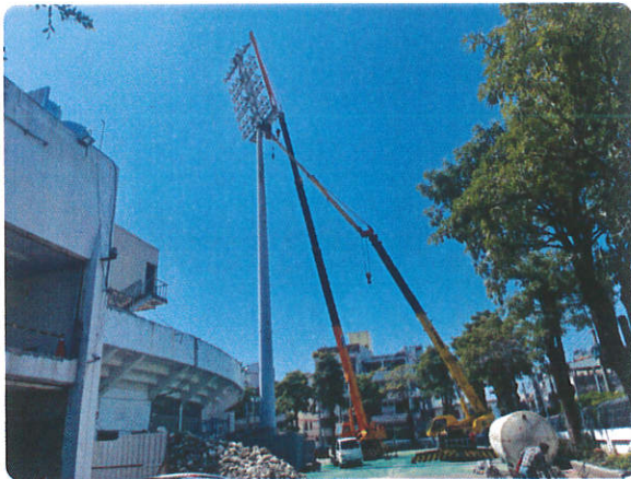
兩台42噸大吊車協同拆卸燈桿
