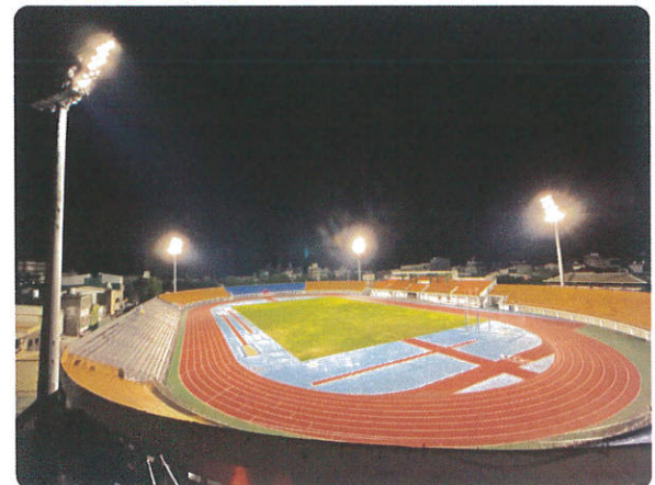
吊車上俯瞰全場
