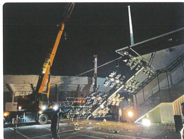
夜間吊掛進行中
