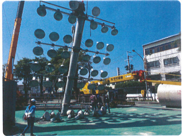
拆下的燈柱高度約8米
