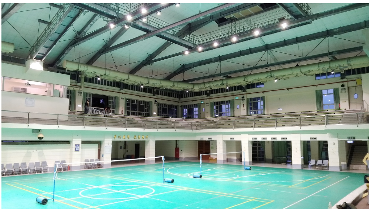
改造後現場照片
