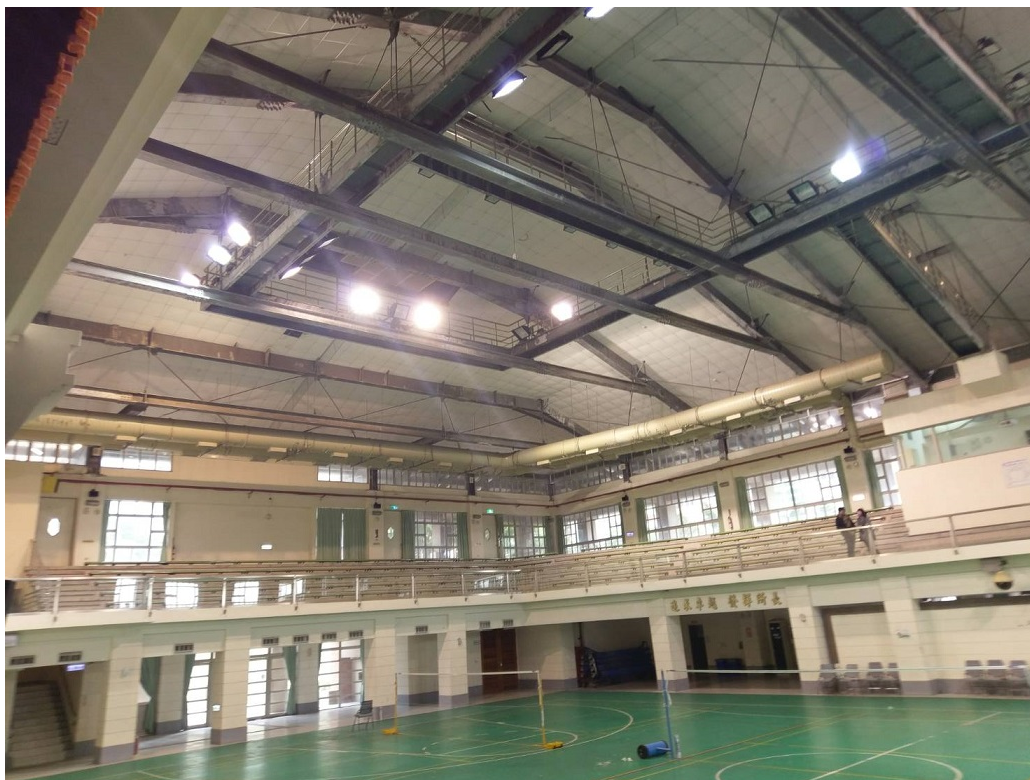
改造前現場照片
